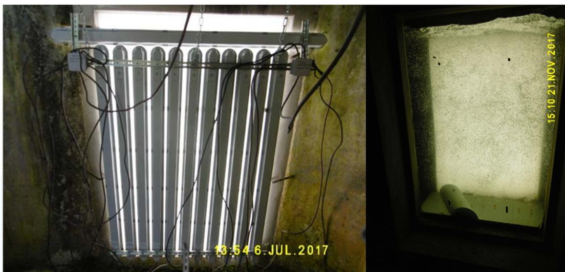
Figure 7 : Remplacement du système d'éclairage et du déflecteur de fond
