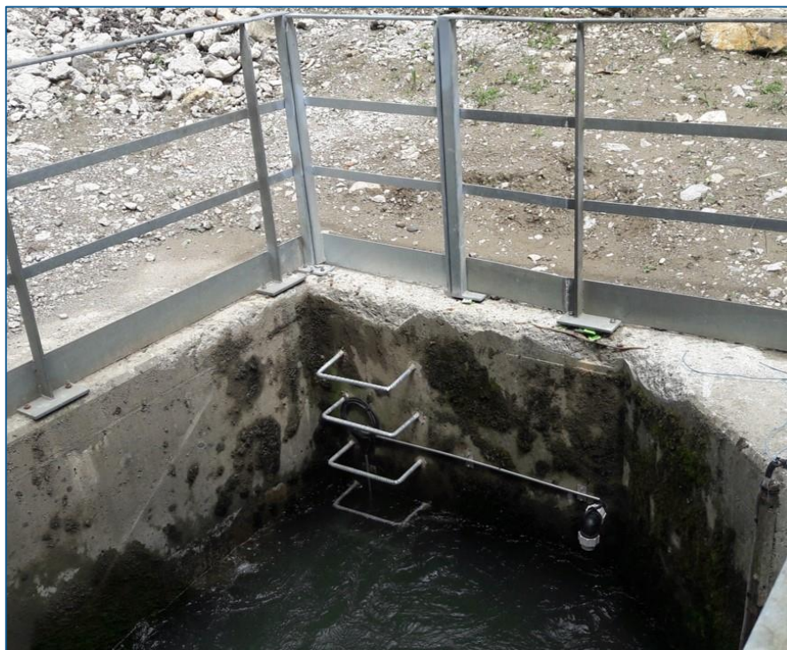
Figure 12 : Vue de l'emplacement de la sonde DS18B20 au niveau du 1 er bassin de la passe à poisson de Castetarbe
