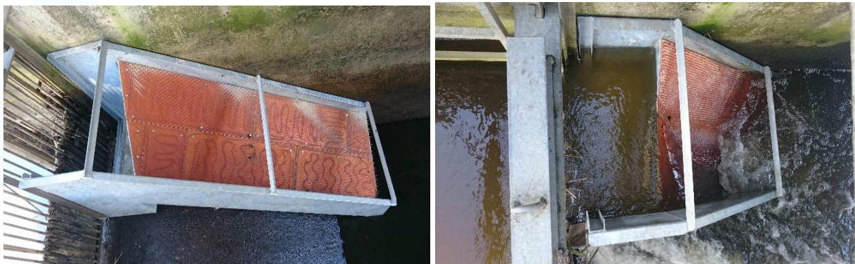
Figure 48 : Vues de la rampe spécifique à anguilles pendant et après son installation au niveau du barrage de Pinsolle en mars 2015
