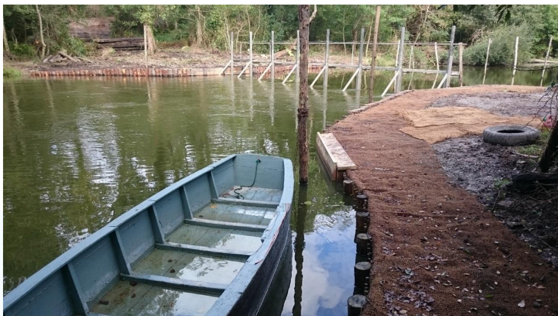
Figure 78 : Vue de la pêcherie d'avalaison après travaux de protection des berges en octobre 2015
