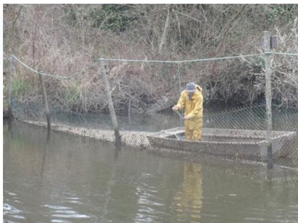
Figure 80 : Vue de la mise en place et vue d'ensemble du défeuilleur amont
