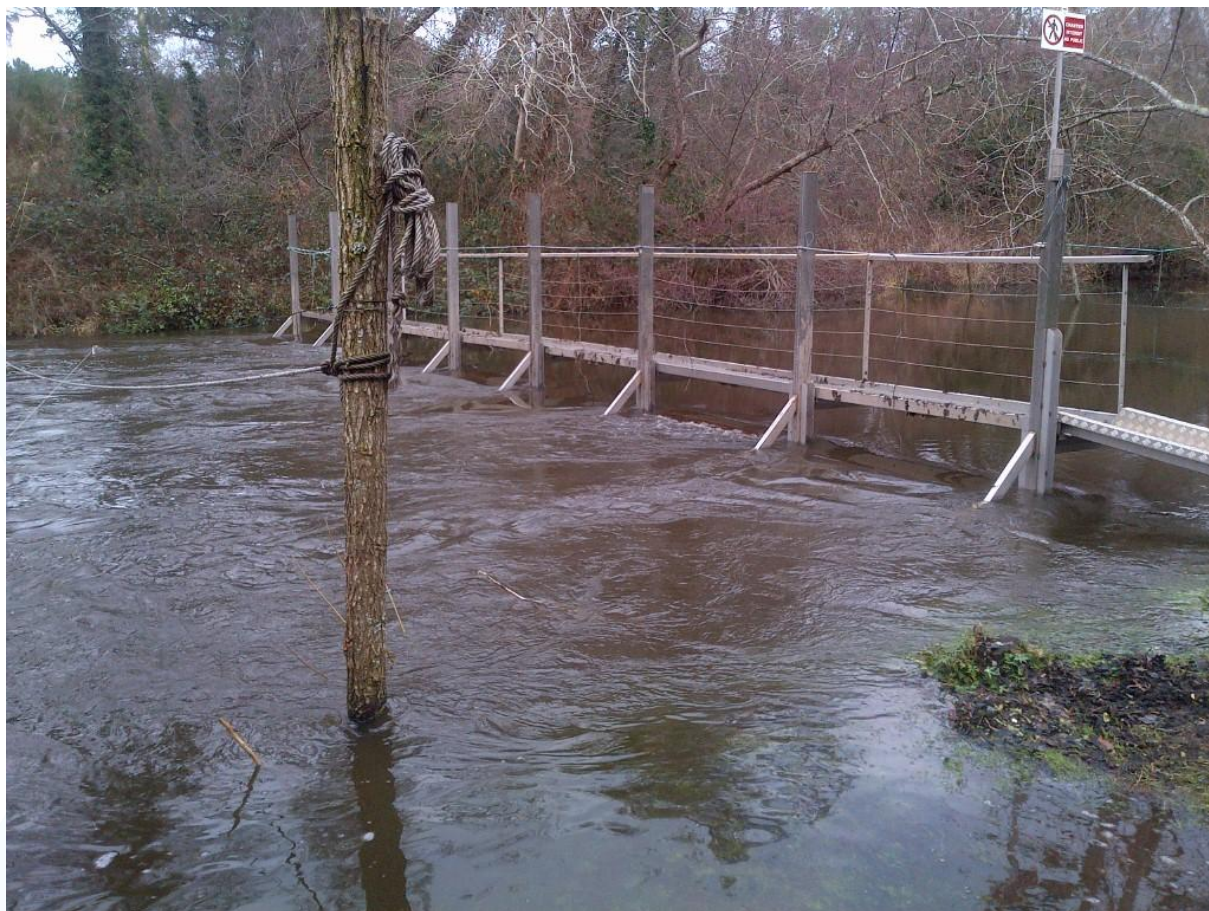
Figure 77 : Vue du dispositif de contrôle par fortes eaux
