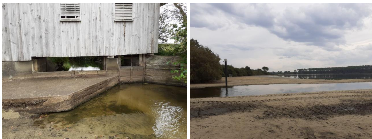
Figure 37 : Vues de l'Etang Hardy partiellement à sec en Septembre 2020
