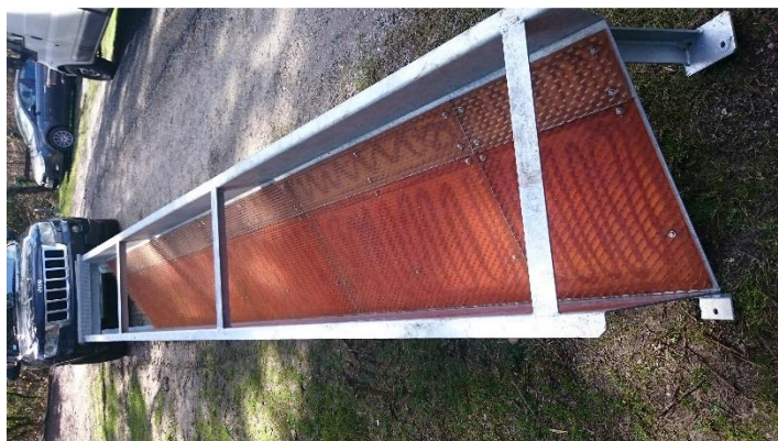
Figure 49 : Vue de la rampe spécifique à anguilles avant son installation au niveau du barrage de Dérivation en mars 2015
