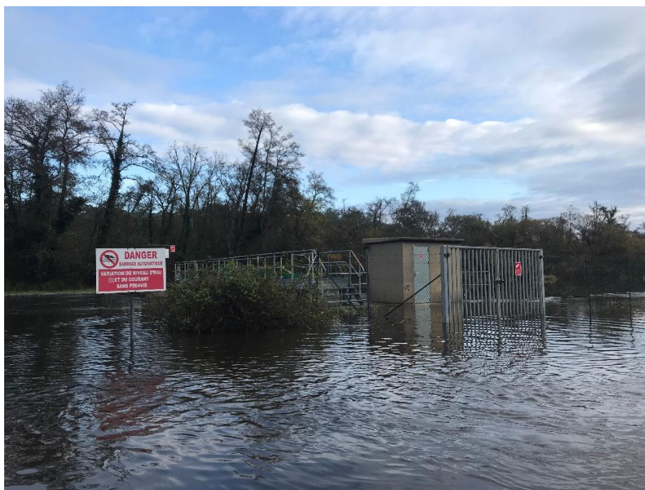
Figure 96 : Vue du barrage et du local de piégeage le 18 Novembre 2019
