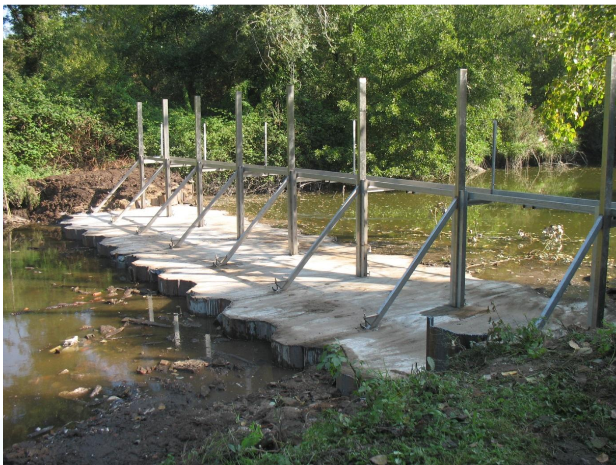
Figure 72 : Vue du dispositif de contrôle après réalisation du radier béton et installation d'une partie de la structure de pêche
