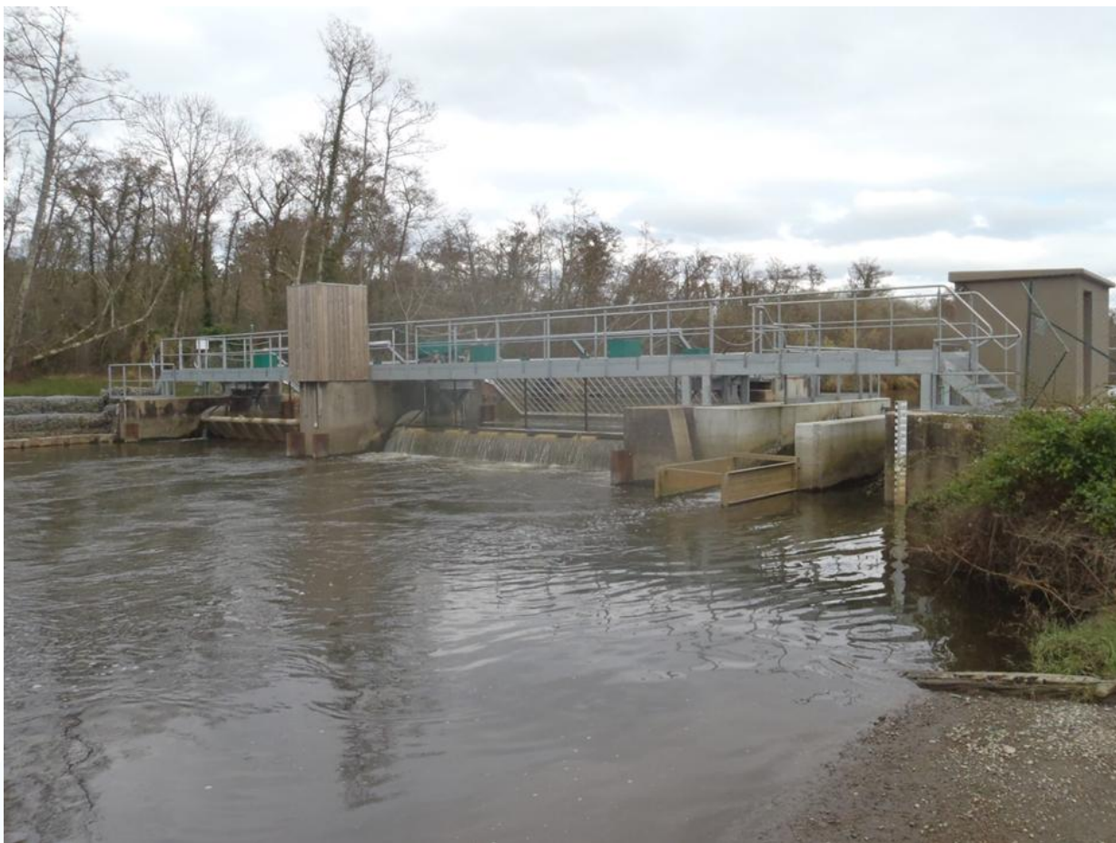
Figure 51 : Vue d'ensemble du barrage de l'Etang de Soustons
