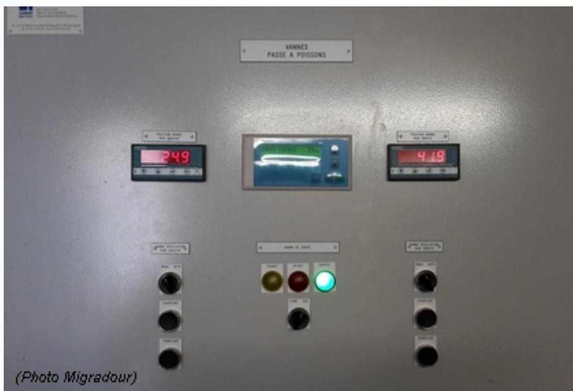
Figure 6 : Automate d'ouverture des vannes aval de la passe à poissons
