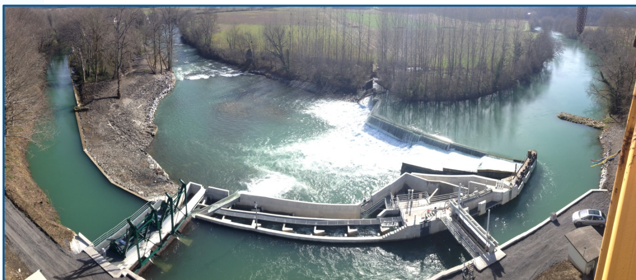
Figure 2 : Vue aérienne du barrage de Charritte
