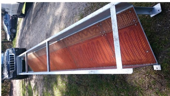
Figure 46 : Vue de la rampe spécifique à anguilles avant son installation au niveau du barrage de Dérivation en mars 2015
