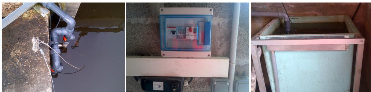
Figure 52 : Vues des 2 pompes d'alimentation, du tableau électrique et du système de "trop-plein"
