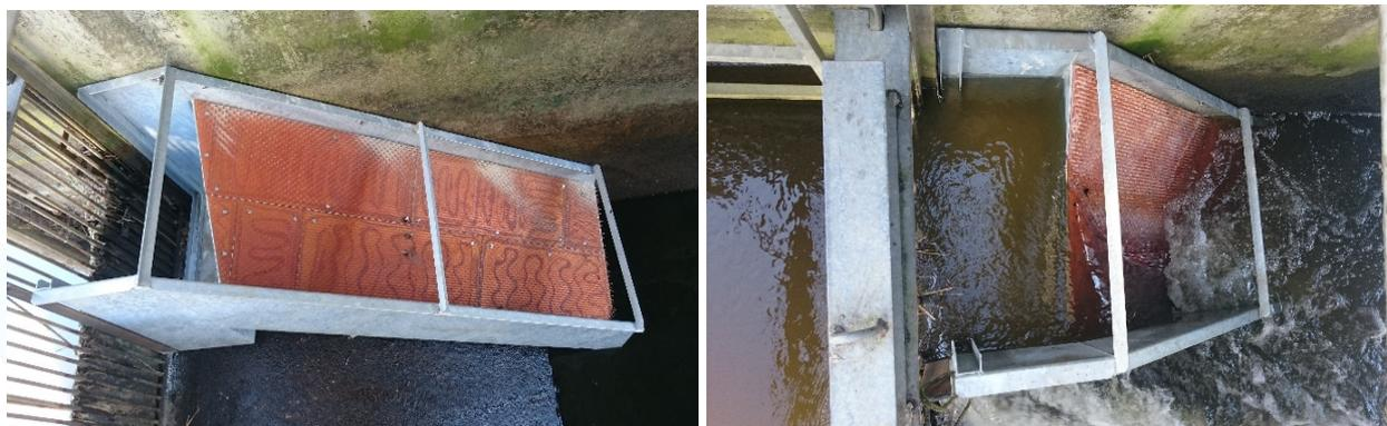
Figure 45 : Vues de la rampe spécifique à anguilles pendant et après son installation au niveau du barrage de Pinsolle en mars 2015
