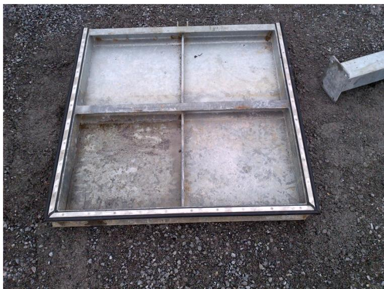
Figure 51 : Vue de la vanne amont de piégeage après pose d'un joint d'étanchéité
