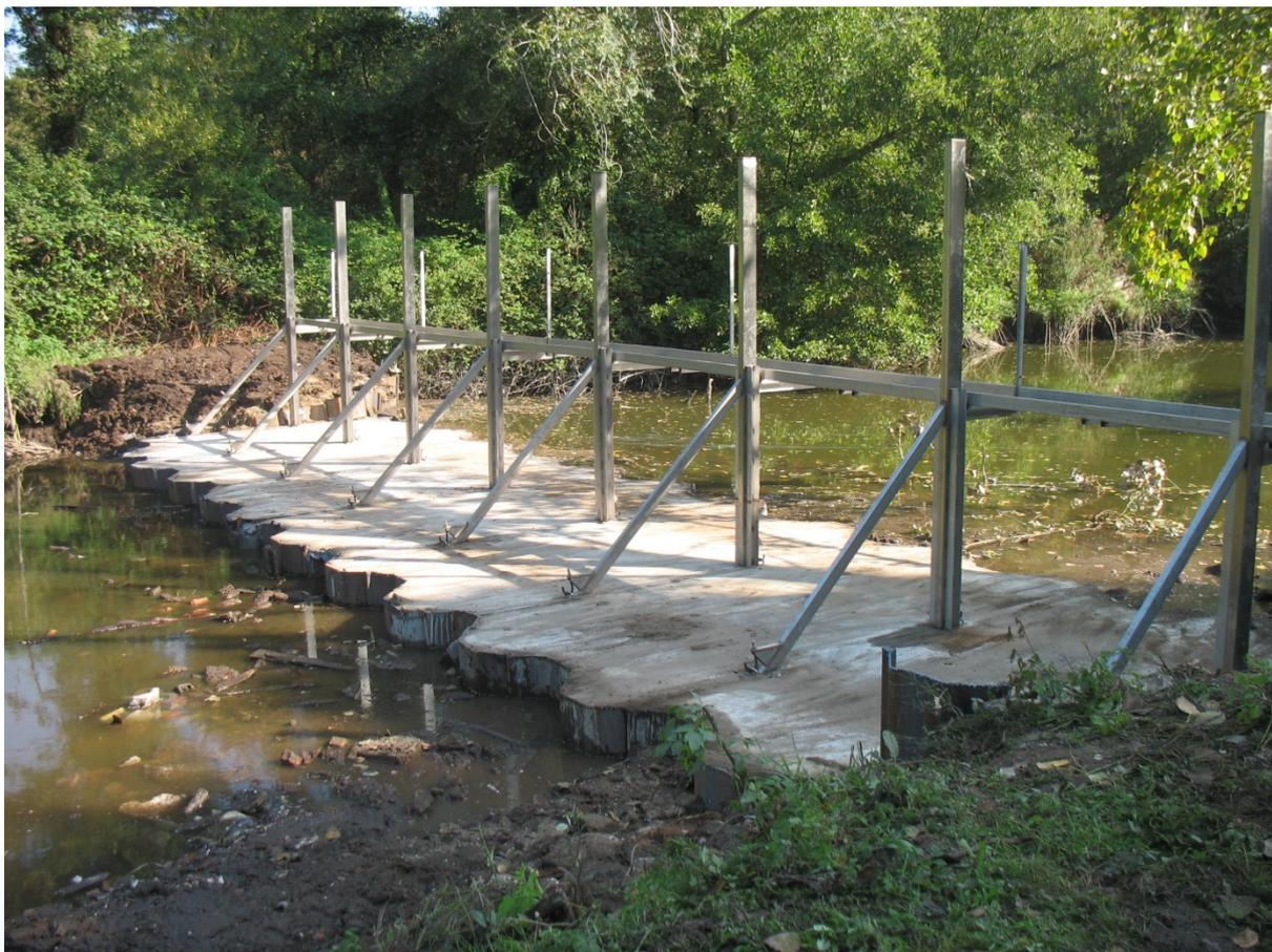
Figure 68 : Vue du dispositif de contrôle après réalisation du radier béton et installation d'une partie de la structure de pêche
