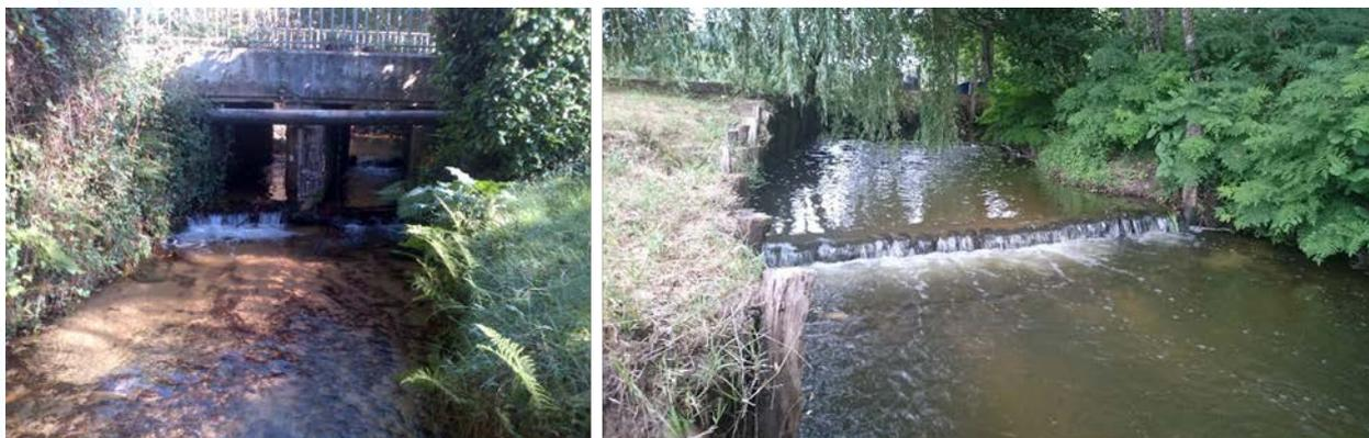
Figure 43 : Vue des Seuils "Pont aval Pérouge" sur le Bouyic et "Hillon" sur le ruisseau d'Hardy
